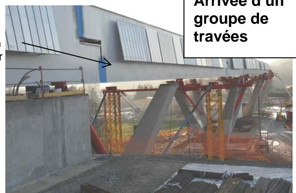
Zone de liaison des travées par soudure
