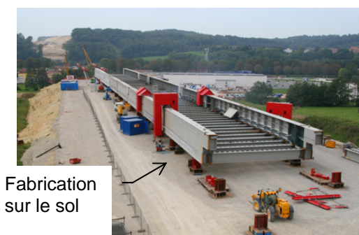
Zone de liaison des travées par soudure
